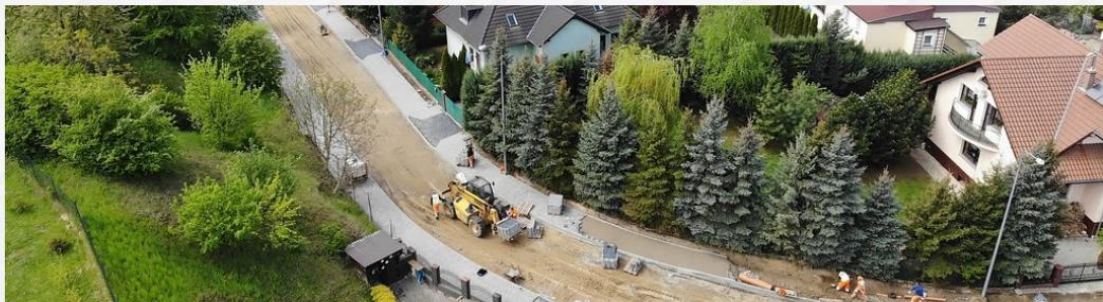
Przebudowa ul. Grota-Roweckiego, ul. Szarych Szeregów i ul. Łąkowej w Trzebnicy
