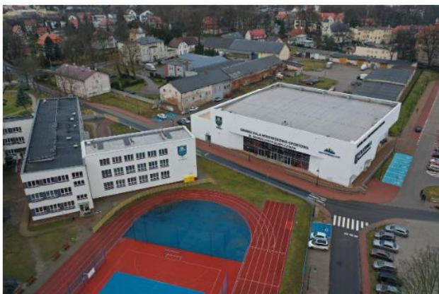
Rozbudowa SP nr 2 w Trzebnicy o nowe skrzydło dydaktyczne
