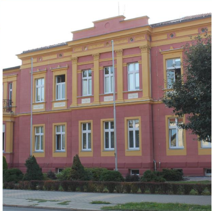
Oleśnica (gmina wiejska) ← III
